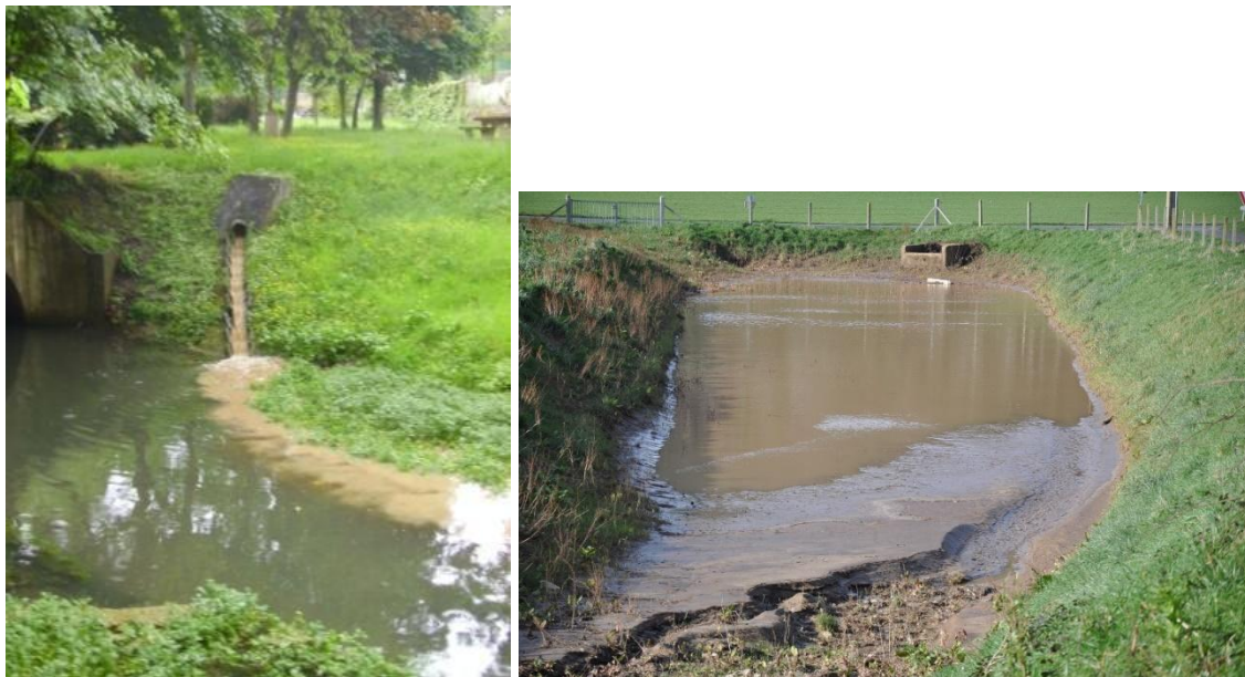
Photo 3 (gauche). Comblement d'un bassin de rétention en Seine Maritime par les matériaux érodés dans les parcelles agricoles (2019, D. Delahaye). Photo 4 (droite). Ruissellement se déversant dans un cours d'eau dans le Calvados (2010, V. Viel).
