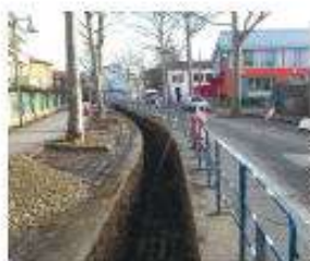
Extension de réseau à Vénissieux.
