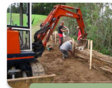
Appui à la mise en œuvre
