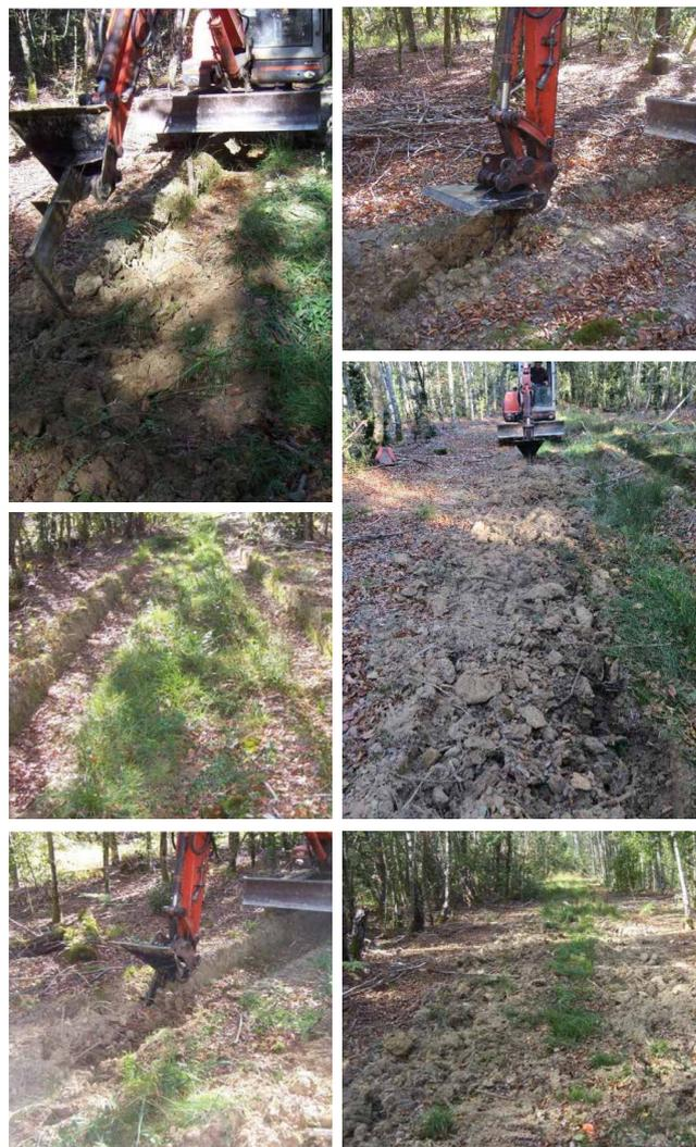
↑ **Figure 5.** Utilisation d'une dent de sous-solage pour drainer des ornières profondes sur sol limoneux – essai en FD de Chauv. Source : FCBA.
