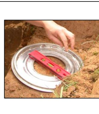
2. Poser sur le sol le gabarit en le fixant à l'aide des clous. Vérifier la planéité avec le niveau.
