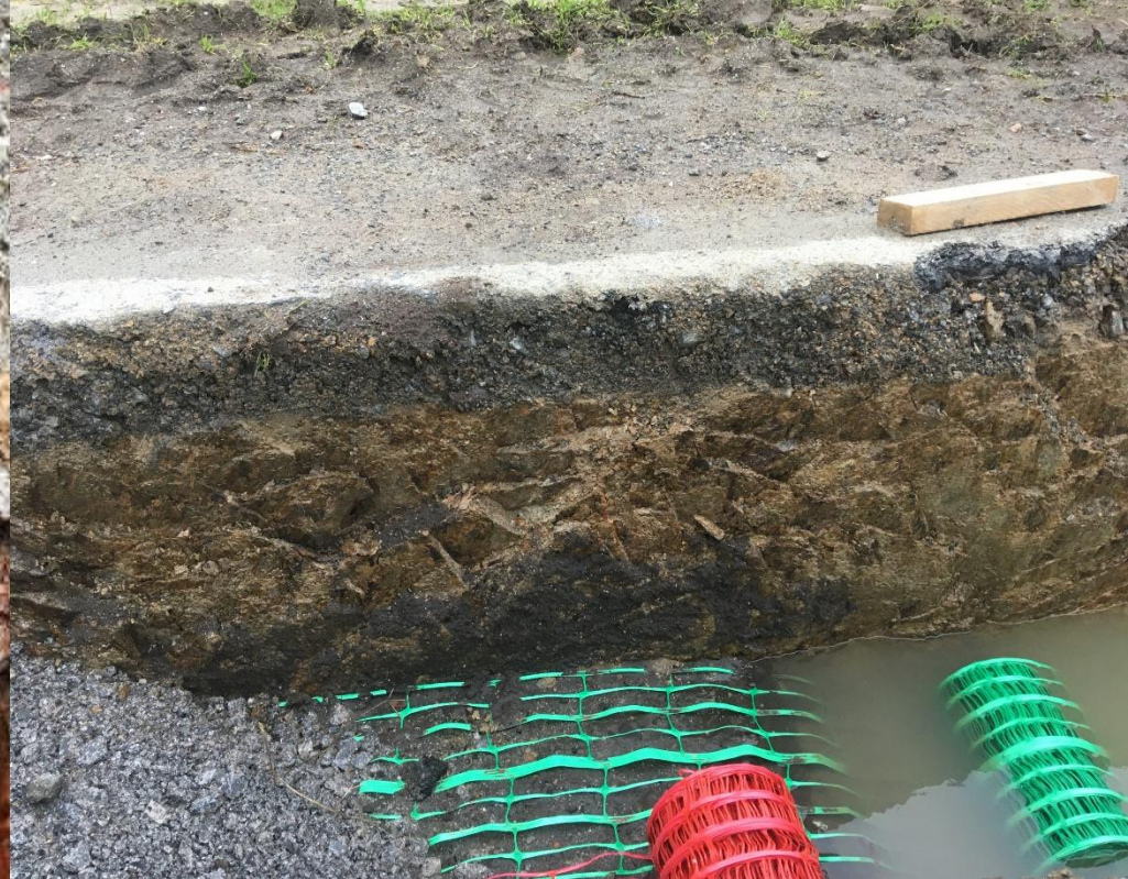
Sol totalement tronqué, sur roche « portante » (Installation réseau/ voirie)
