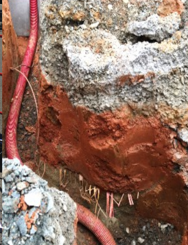
Sol en partie tronqué, recouvert (recouvrement réseau)
