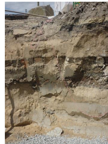
Crédit Vivien Baudouin, BRGM
